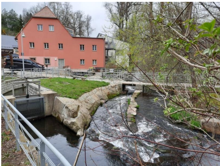
Bild 1: ökologische Durchgängigkeit und Wasserkraftnutzung sind im Einklang – historische Wassermühle mit 30 PS Wasserrad und Fischwanderhilfe – erneuerbarer Grundlaststrom für 50 Haushalte bei 120.000 kWh Jahreserzeugung möglich
